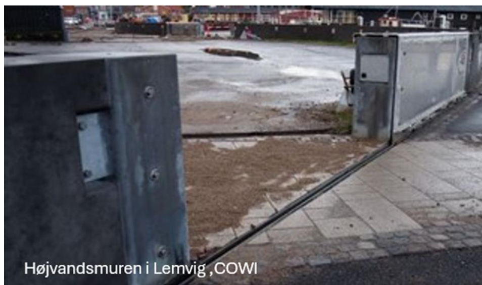
Figur 3-8 Højvandsmur i bymæssig bebyggelse giver både højvandsbeskyttelse og mulighed for passage igennem muren via højvandsskot som lukkes ved varsel om stormflod. Foto: Peter F. Klagenberg, COWI.
